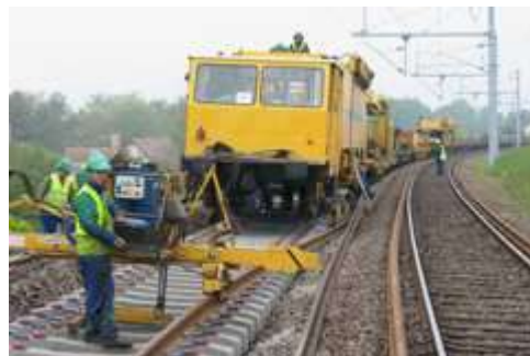
Longs rails soudés sur traverses béton
